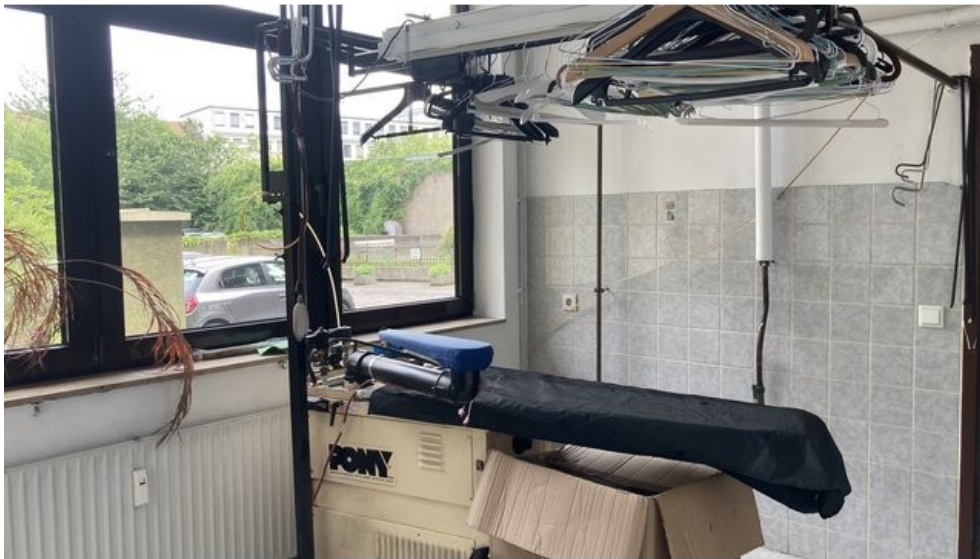
Bereich Richtung Hinterhof
